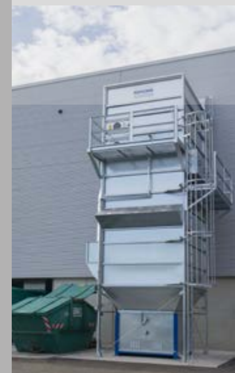
MultiStar filtersysteem met BrikStar C briketpers van één fabrikant van golfkartonnen verpakkingen. Kritische stoffen kunnen veilig in briketvorm worden opgeslagen.
