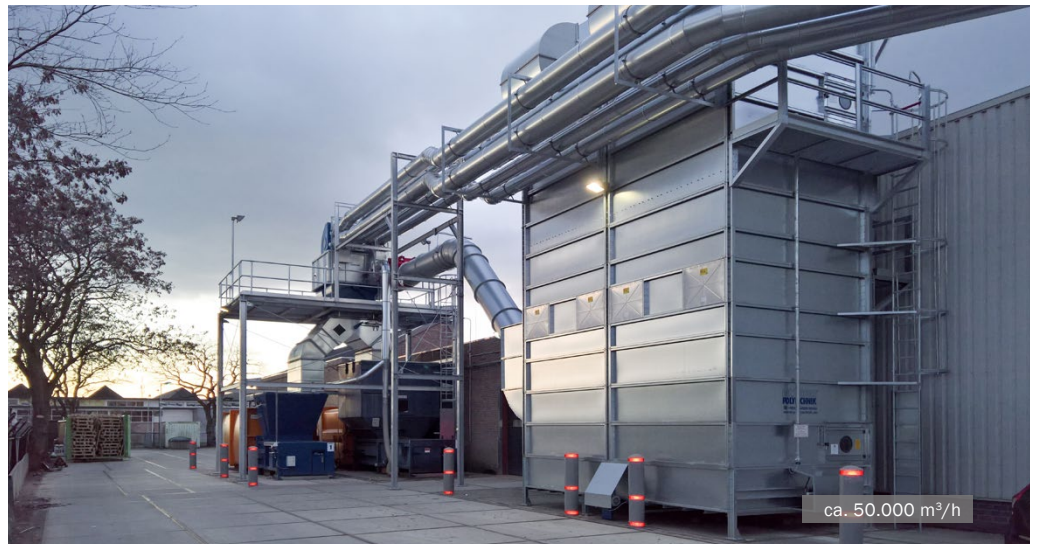
MultiStar schuifvloerfilter met jetreiniging • Druk- en verpakingsindustrie
