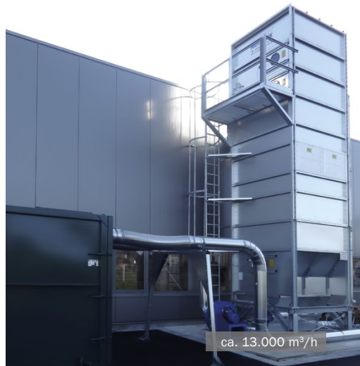
MultiStar sluisfilter met containervulling
