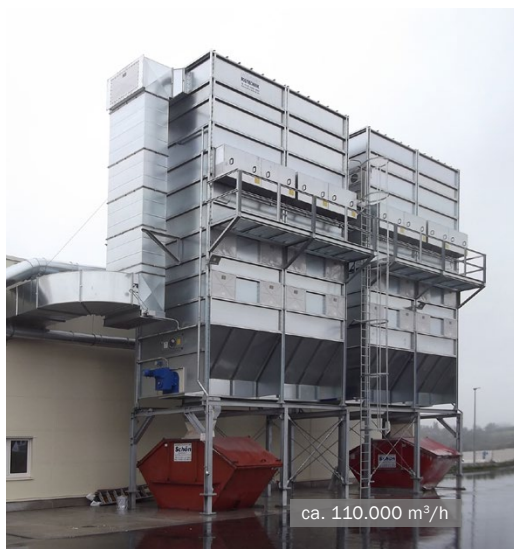
MultiStar vijzelfilter met jetreiniging • Binnenuitbouw
