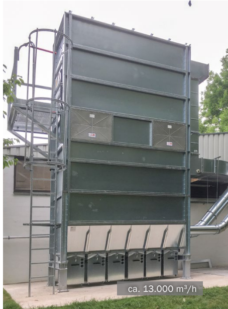
MultiStar tonafzakfilter in de houtverwerking
