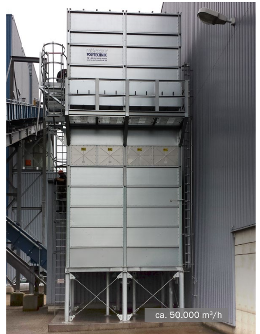
MultiStar roerwerkfilter • Biomassacentrale
