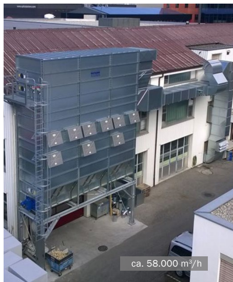
MultiStar vijzelfilter met spoellucht • Binnenuitbouw
